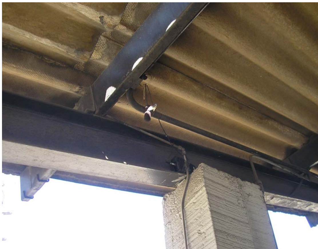
Foto 1 – Local de fixação do medidor de nível de pressão sonora (próximo a posição 6 da fig. 2).
